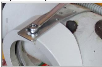
6.4.4. Установить на трубу и зафиксировать второй хомут на 2 болта.
